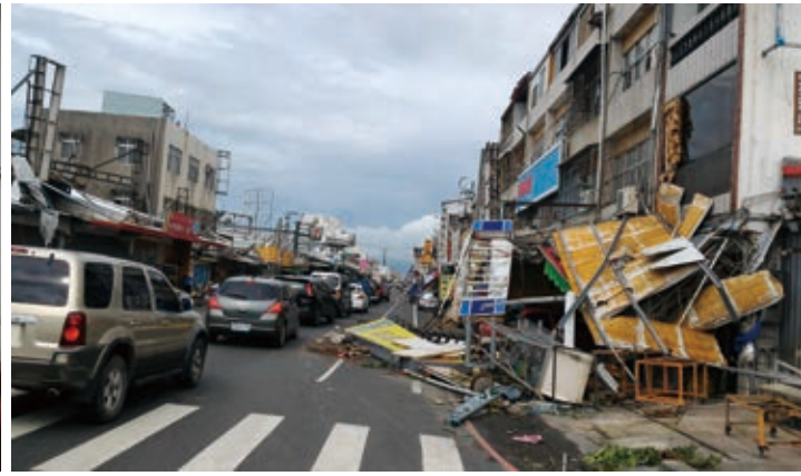
■台東市區招牌路樹倒塌，怵目驚心
