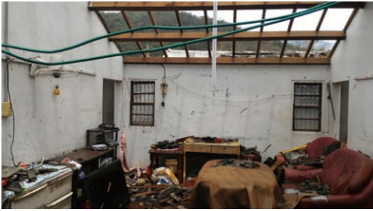
■香蘭村多處民宅屋頂被掀、屋牆倒塌、家具全毀
