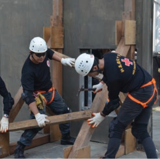
■南區訓練：震災後建築物倒塌時的牆面支撐
