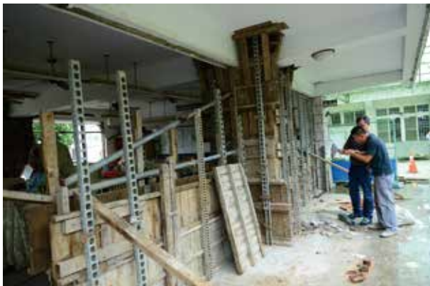
■ 訪視臺南市北門國中修繕進度
