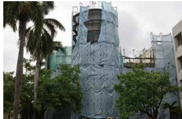
■ 屏東縣鹽埔國中行政大樓外牆修繕
