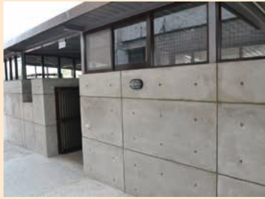
■嘉義縣溪口國小運動館後側的衛浴、儲物間
